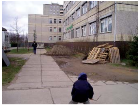
Der Eingangsbereich im März 2004...
